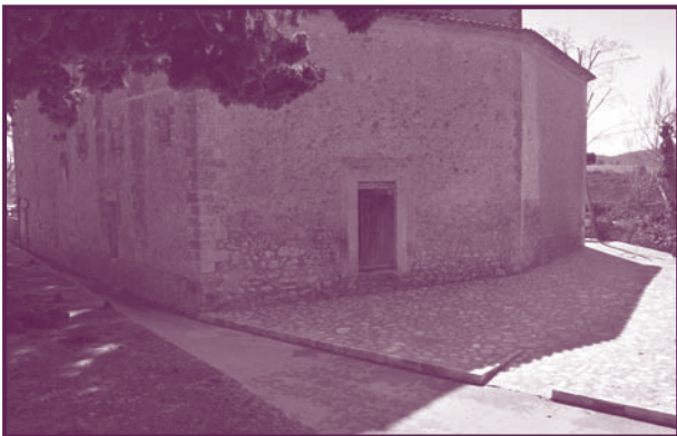
Espai de l'oratori rehabilitat
